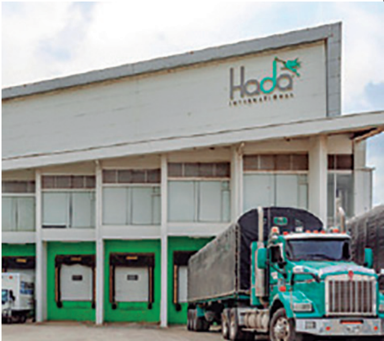
BODEGA ZONA FRANCA LA CAYENA -Juan Mina
