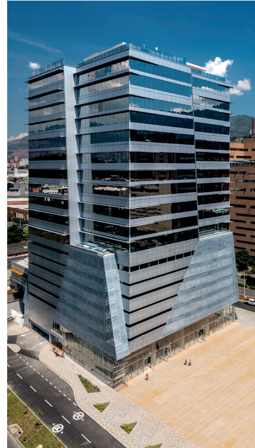
EDIFICIO RIVANA BUSINESS -Medellín
