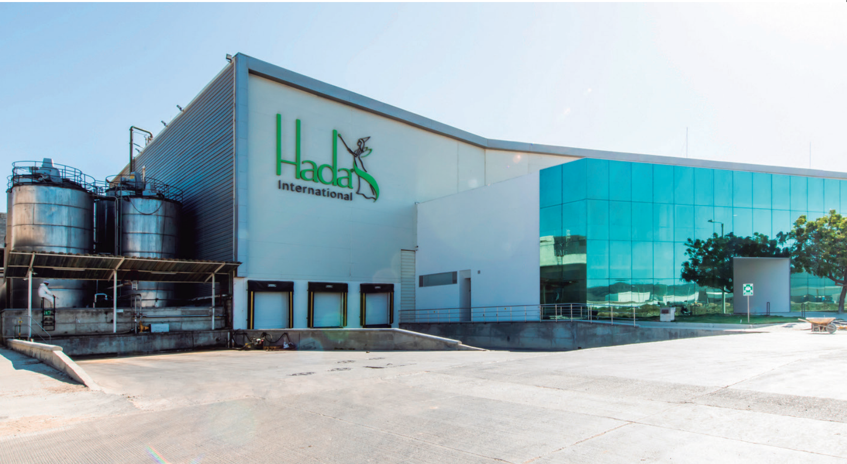
BODEGA ZONA FRANCA LA CAYENA -Juan Mina
