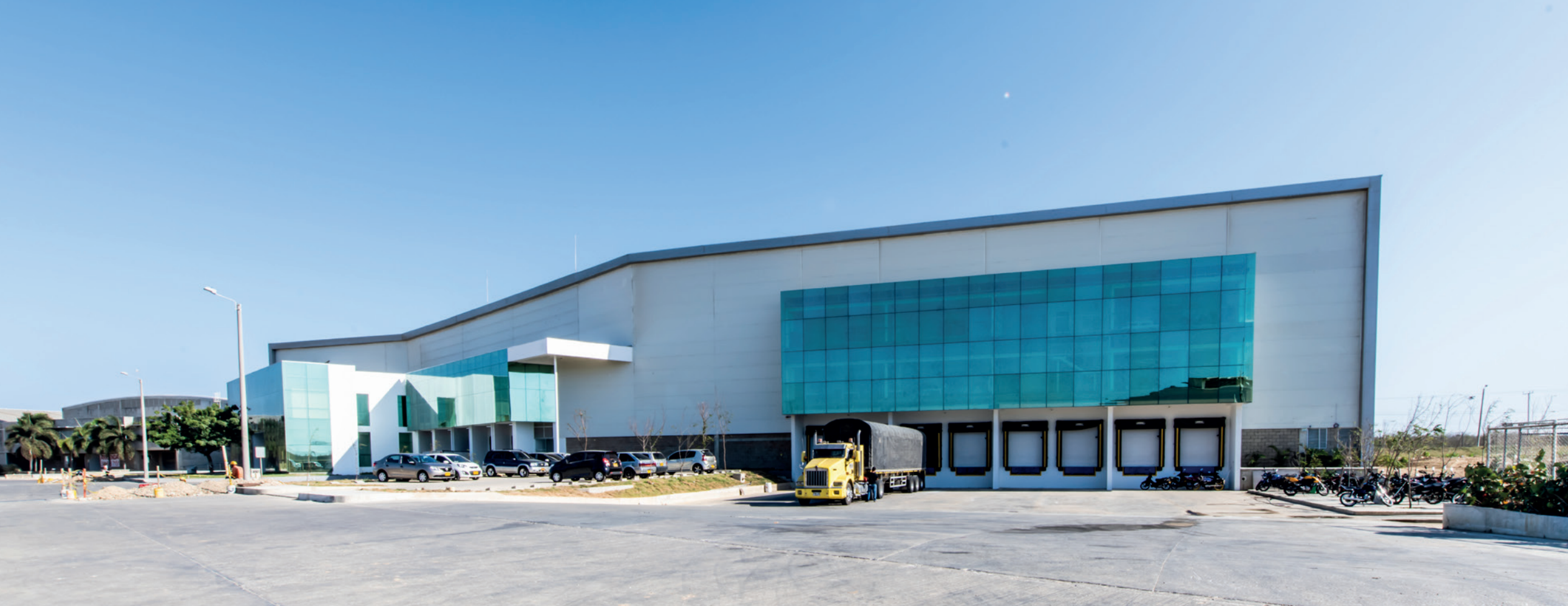
BODEGA ZONA FRANCA LA CAYENA -Juan Mina
