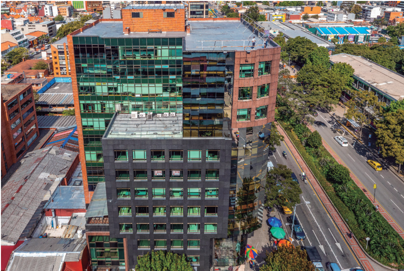
DAVIVIENDA CALLE 72 -Bogotá
