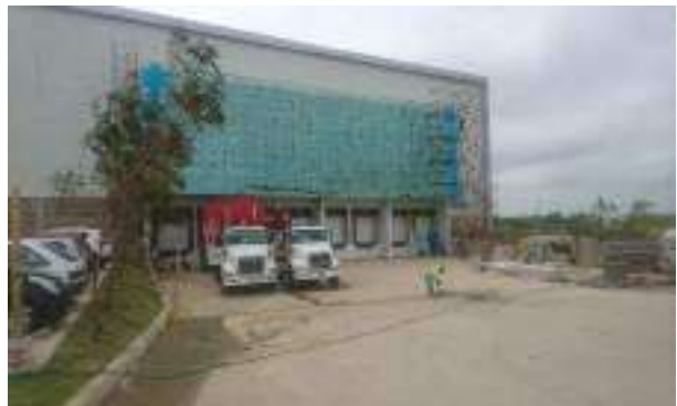
Muelles de carga y descarga
