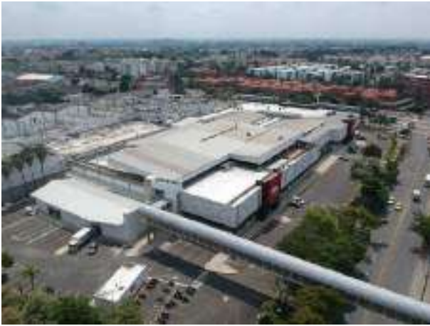
Vista General de la Propiedad
