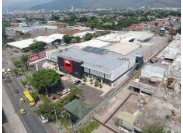
Vista General de la Propiedad
